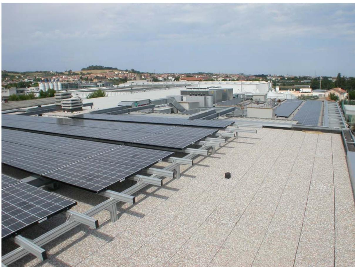
Le strutture di sostegno, aventi uno sviluppo lineare di quasi 500 metri lineari, sono realizzate con componentistica che stiamo sviluppando specificatamente per il settore.
